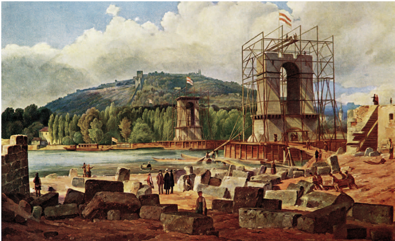
K. Würbs, Stavba řetězového mostu v Praze roku 1840
