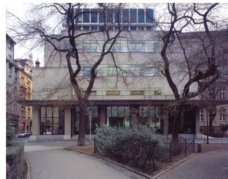
➤ Edisonova transformační stanice v Praze – jedna z úspěšných realizací arch. Lábusa.
